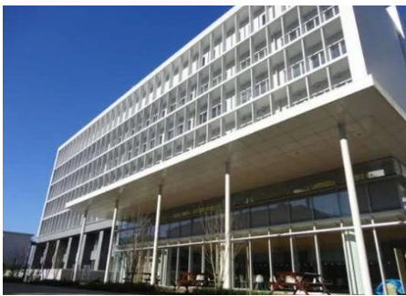
本庁舎 太陽光発電設備(茅ヶ崎)
