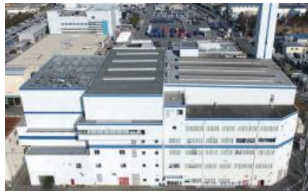
環境事業センター 廃棄物発電設備(萩園)
