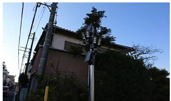
細街路の交差点における自転車走行空間整備社会実験 (人感センサーライトを交差点に設置)
