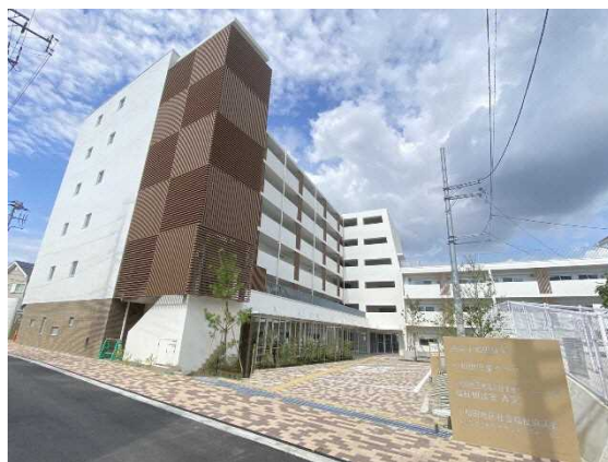
市営小和田住宅外複合施設
