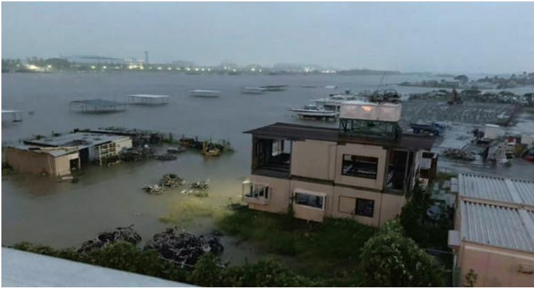
令和元年東日本台風で水位上昇した相模川(中島馬入橋付近で撮影)。氾濫の恐れがある水位までと40cmだった
