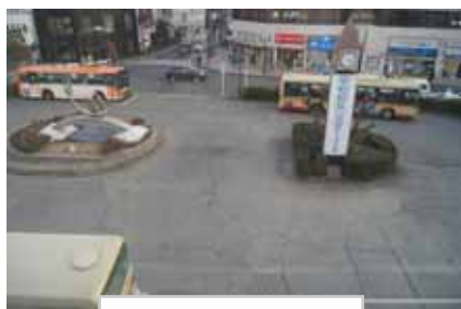
舗装の劣化、損傷
