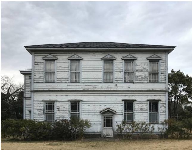
南側立面（通用口側）
