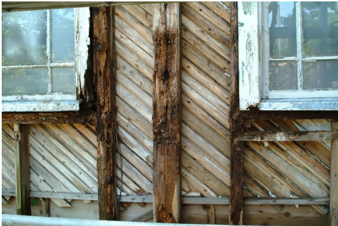
平成 14（2002）年度改修工事前
