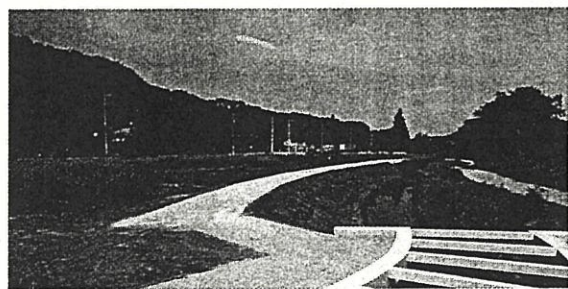
駒寄川下流域部の護岸工事は既に完了済み
