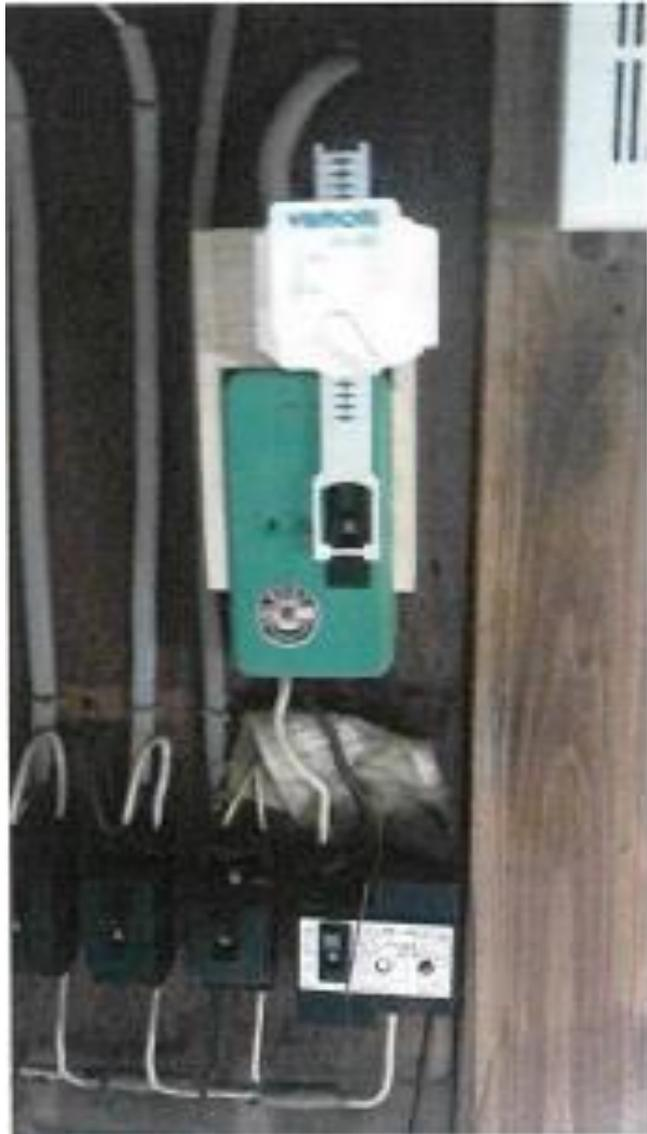
むき出しの分電盤には、補助板を使用して、設置可能な場合があります。
