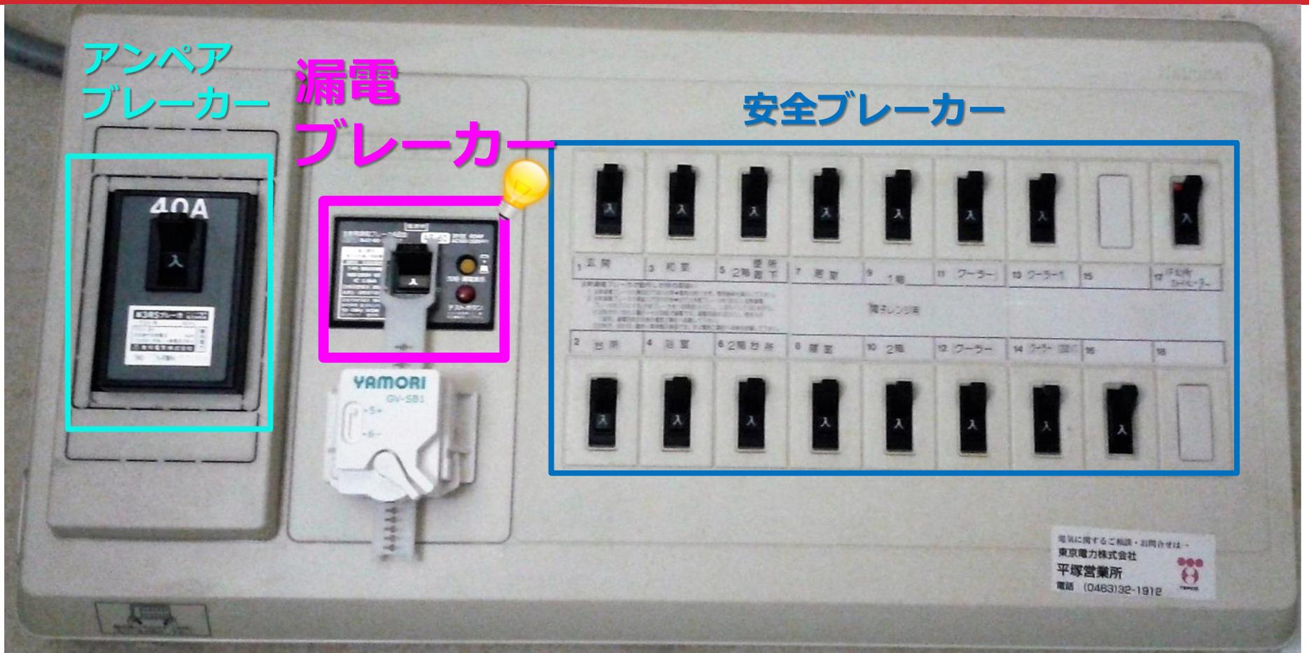
**アンペアブレーカー**：契約アンペア数を超えると電気遮断
