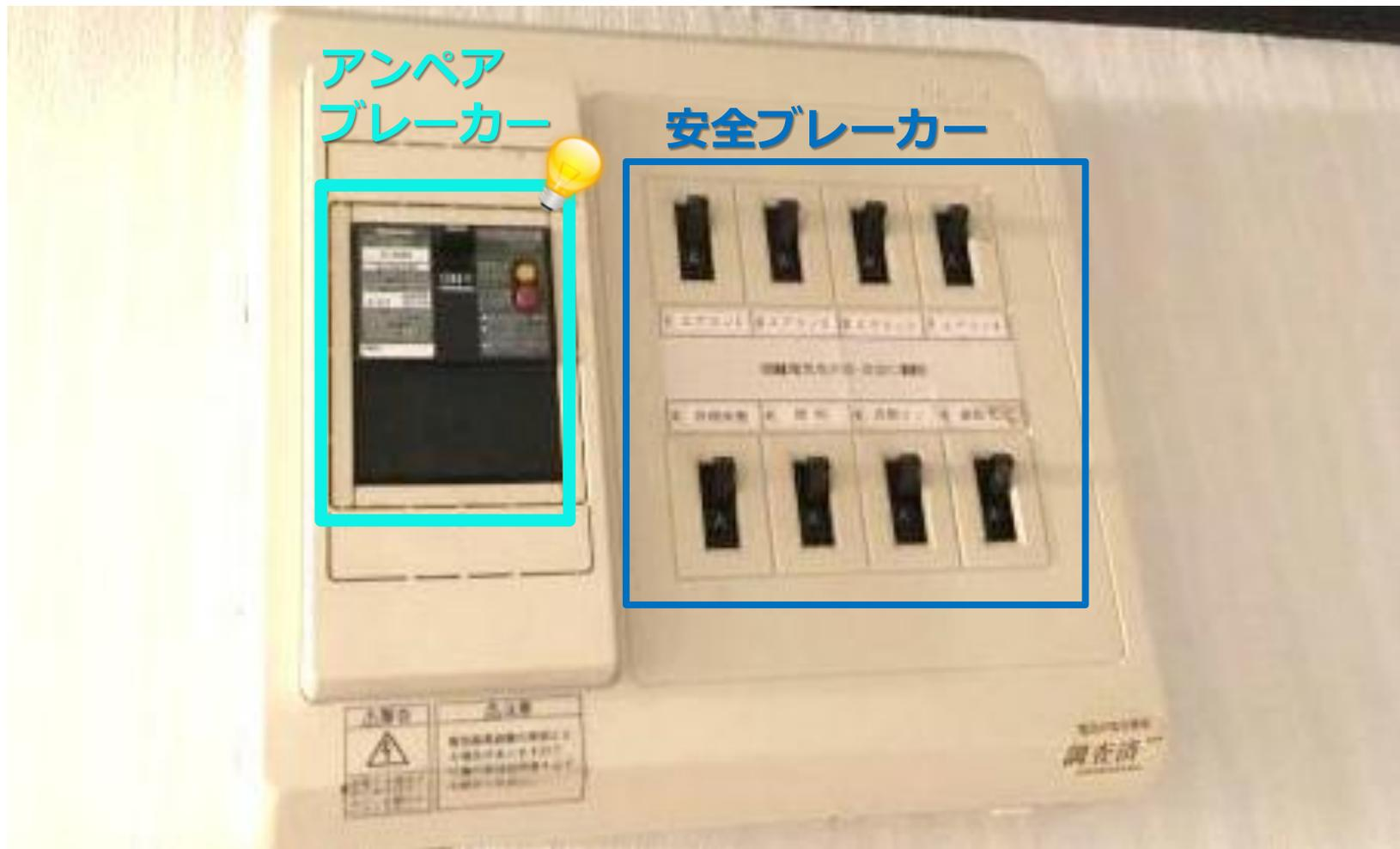
**アンペアブレーカー**：契約アンペア数を超えると電気遮断
