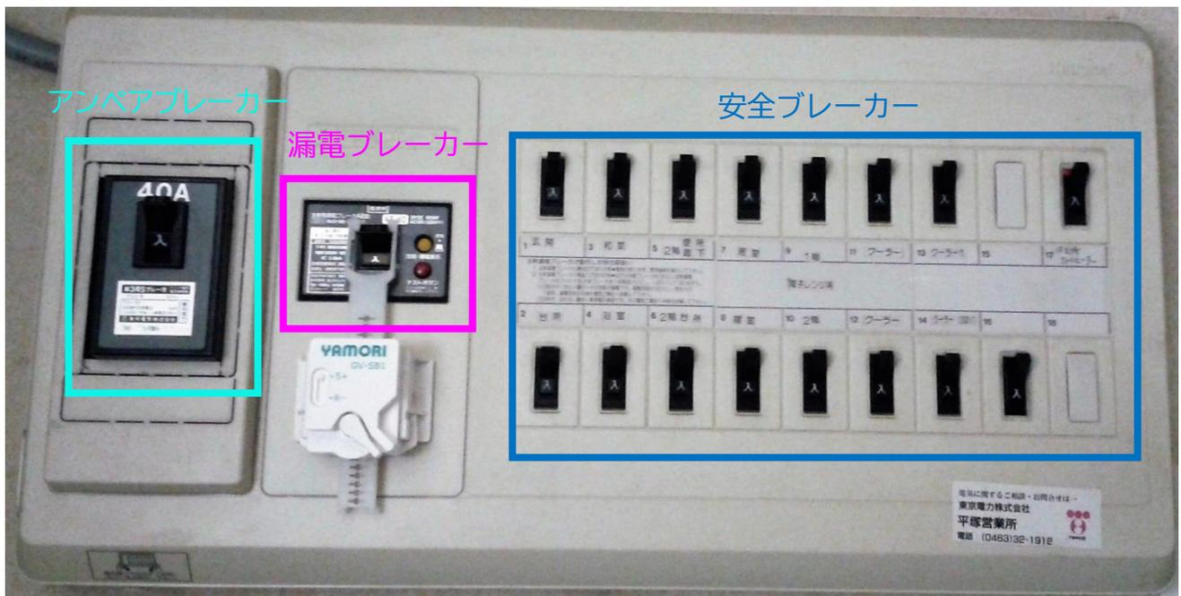
※アンペアブレーカー：ご自身が契約している電流量（アンペア数）を、家庭全体で超えると電気の供給を自動で止める装置です。
