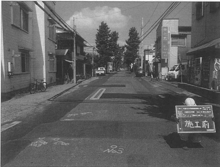
施工状況写真 市道5634号線道路整備工事 施工前 No. 3
