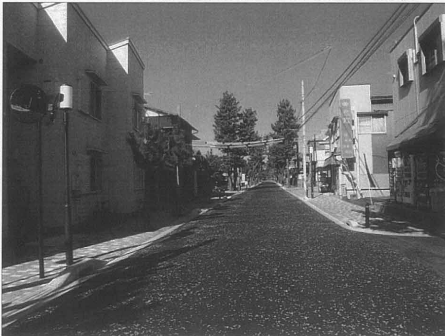
施工状況写真 市道5634号線道路整備工事 完了 No. 3
