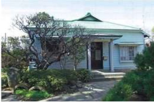
玄関を中心にした東面
