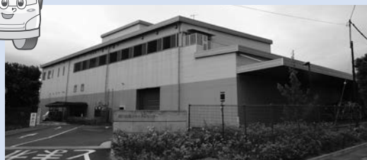
寒川広域リサイクルセンター
