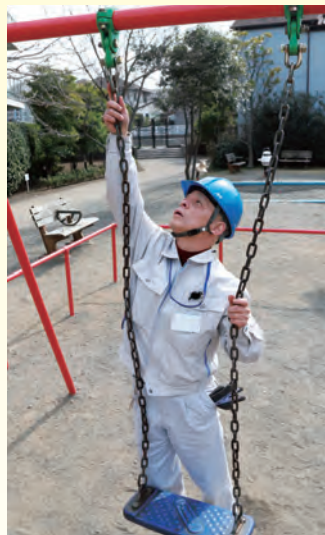
金具の劣化具合を確認
