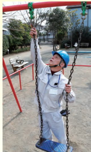
金具の劣化具合を確認
