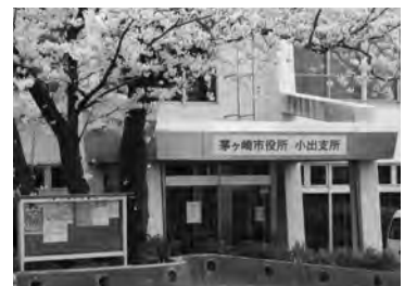
耐震補強、施設改修が行われる小出支所
