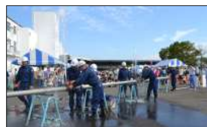
水道管応急復旧訓練
