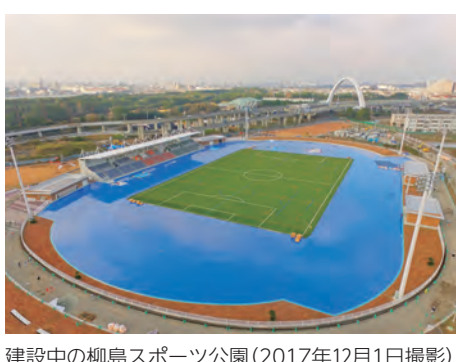
建設中の柳島スポーツ公園(2017年12月1日撮影)
