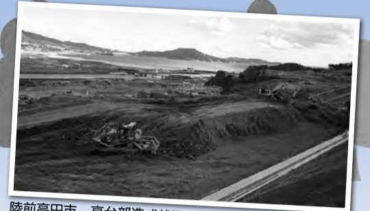
陸前高田市 高台部造成状況(三陸沿岸道路部)
