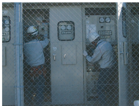
高圧受電設備の点検の様子
