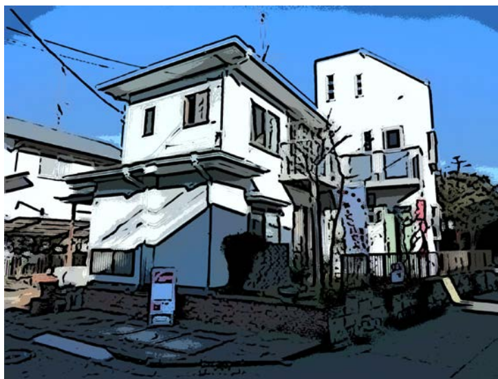
管理がされている空き家の外観
