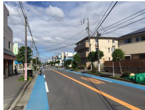
(左)鉄砲道の一中通りから学園通りまでの約1.5kmに整備された、自転車専用レーン等 平成28年3月供用開始【①】
