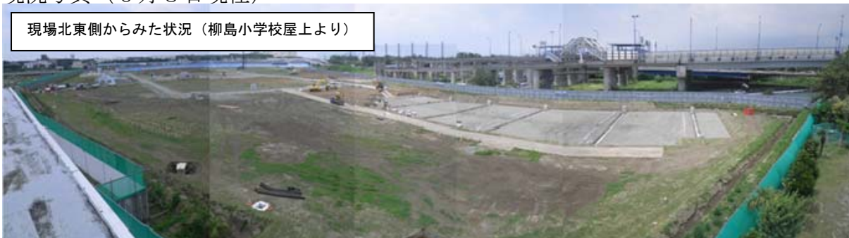
現場南西側からみた状況（国道134号歩道橋より）
