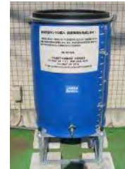
雨水貯留タンク
