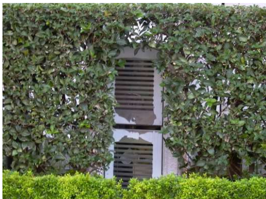
戸建て住宅地におけるメーターボックスの修景例 (柏市)
