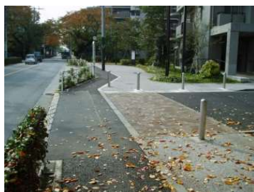
歩道と車道の交差部の舗装材を変え、運転者に注意を促している例 （武蔵野市サンヴァリエ桜堤）
