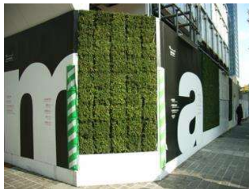
仮囲いをデザインし、コーナー部を壁面緑化した例（丸の内）
