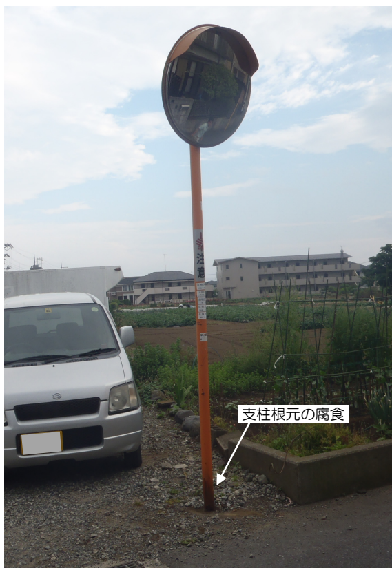
図 2-10 防護柵腐食・損傷 (H25 年度補修前)
