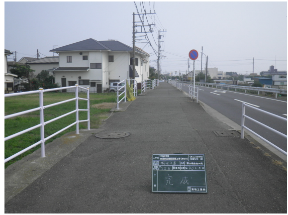
図 2-11 防護柵腐食・損傷 (H25 年度補修後)
