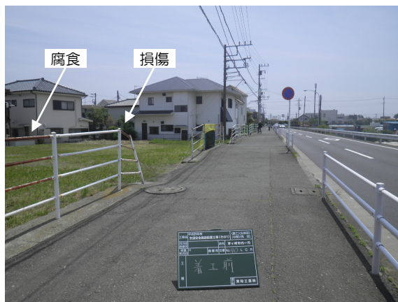
図 2-10 防護柵腐食・損傷 (H25 年度補修前)
