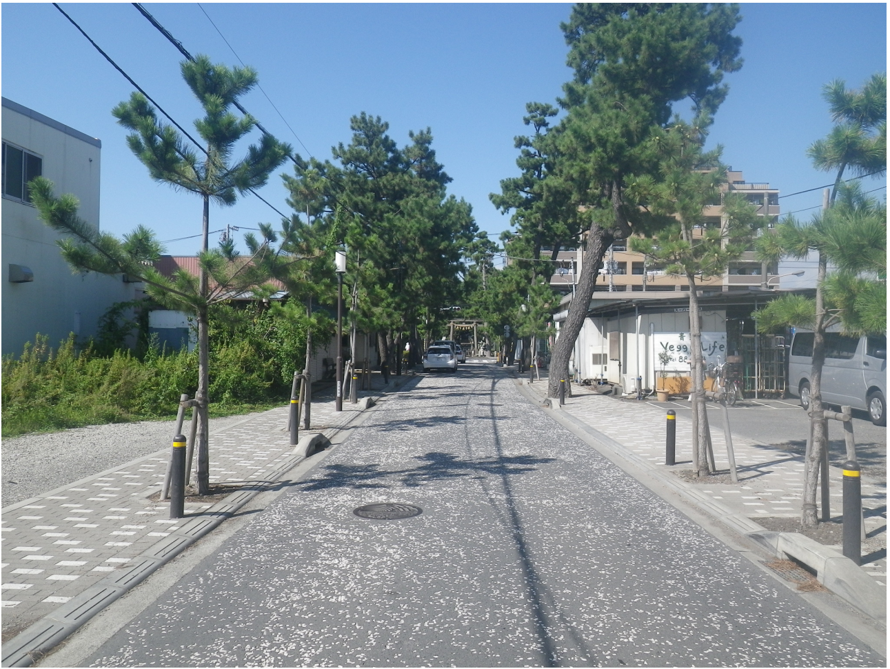
写真 歩道部インターロッキング舗装と車道部ロールド舗装の施工事例（鶴嶺参道）
