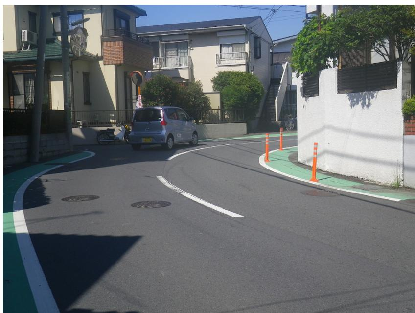
図 6-3 本市におけるカラー舗装及びポストコーンの設置事例（松林通り）
