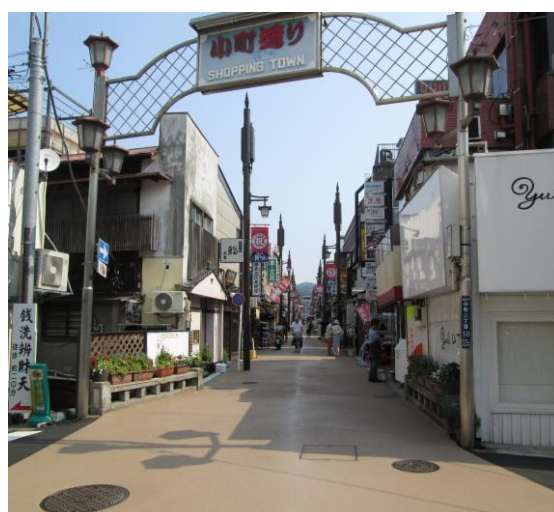
図 6-2 地上変圧器の整備事例（鎌倉市）
