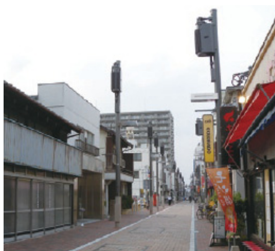
図 6-3 柱上変圧器の整備事例（群馬県高崎市）
