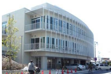
高砂コミュニティセンター (平成24年度設立、屋上に 太陽光発電設備を設置)
