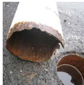
ポール看板の倒壊
