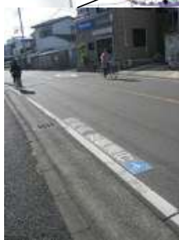
左富士通りの法定外路面標示（600m）
