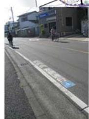
左富士通りの法定外路面標示 (600m)
