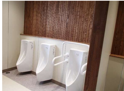
(完成写真 職員用男子トイレ)
