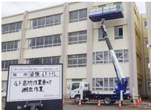
(建設副産物搬出状況)
