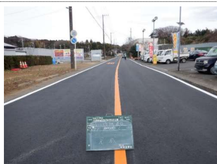
（完成写真）市道 0110 号線
