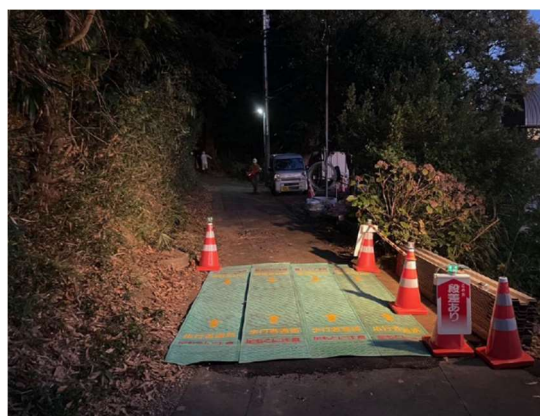
(夜間安全対策写真)
