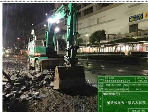
(主たる部分の施工状況写真③)
