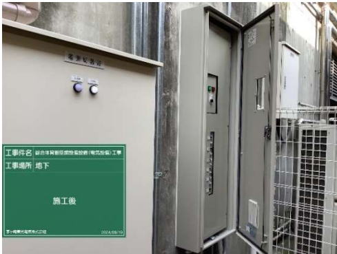
(主たる部分の施工状況写真)
