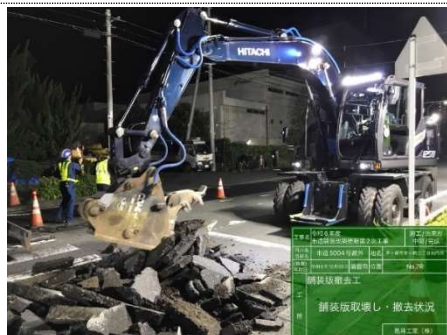
(主たる部分の施工状況写真①)
