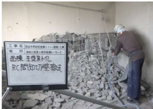
(主たる部分の施工状況写真)
