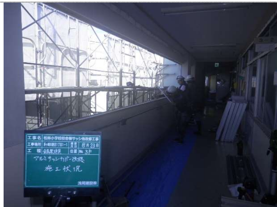
(主たる部分の施工状況写真)
