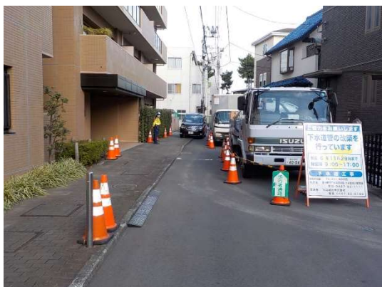
（主たる部分の施工状況写真②）
