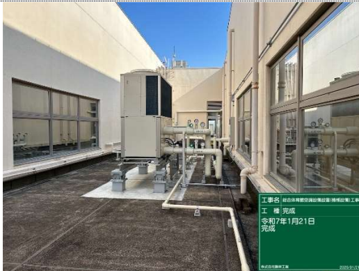
(主たる部分の施工状況写真)
