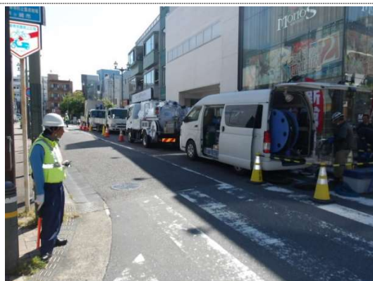
(主たる部分の施工状況写真)
