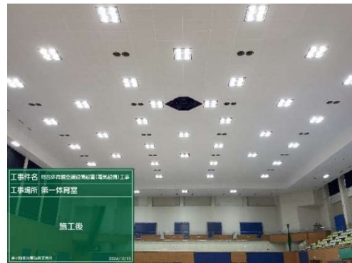
(第一体育室完成写真)
