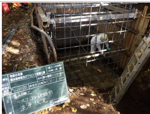
(主たる部分の施工状況写真)
