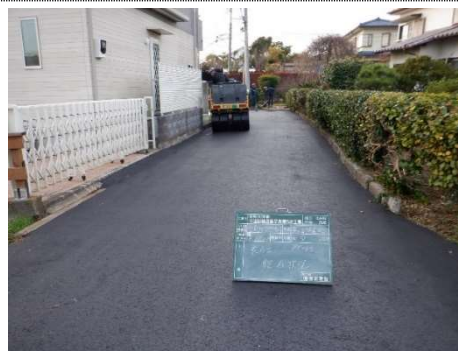
（主たる部分の施工状況写真③）市道 7378 号線
