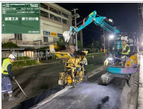
(主たる部分の施工状況写真②)
