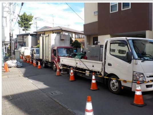
（主たる部分の施工状況写真①）
