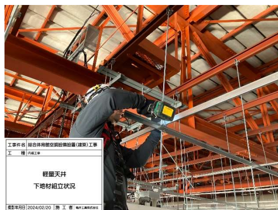
（軽量鉄骨天井下地材組立）
