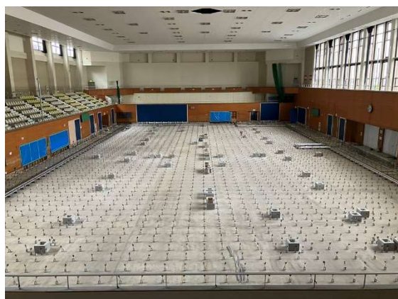
（第一体育室床施工状況①）
