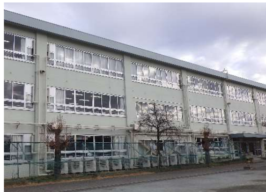
(完成写真 校舎棟南面)
