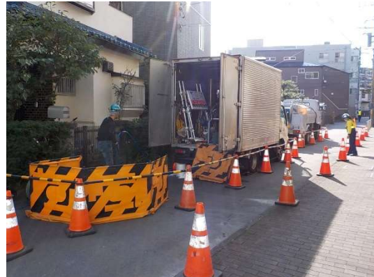
（主たる部分の施工状況写真③）
