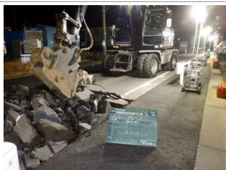
（主たる部分の施工状況写真①）市道 0110 号線
