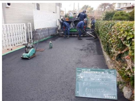
（主たる部分の施工状況写真②）市道 7378 号線
