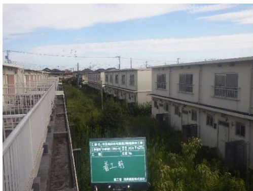
(着工前状況写真)
