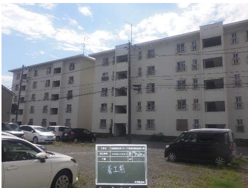
(着工前状況写真)
