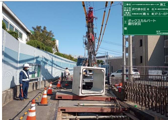
(主たる部分の施工状況写真)
