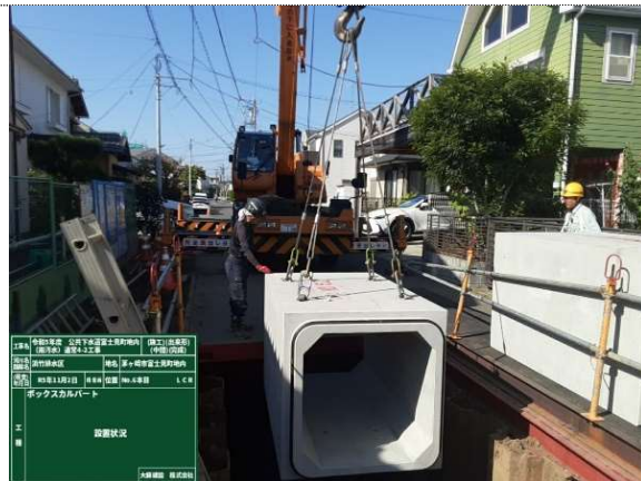
(主たる部分の施工状況写真)
