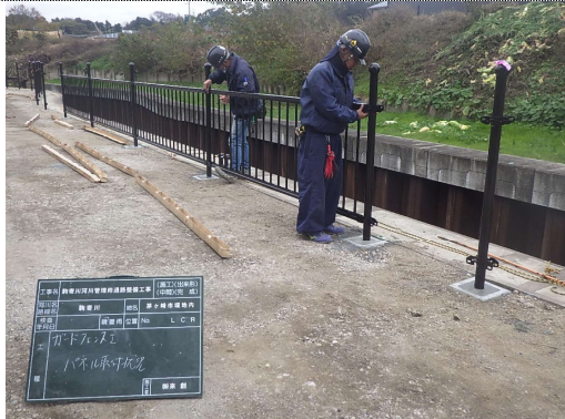
(主たる部分の施工状況写真)
