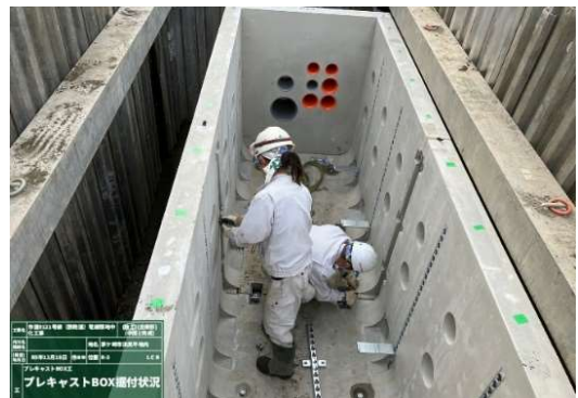
(主たる部分の施工状況写真2)
