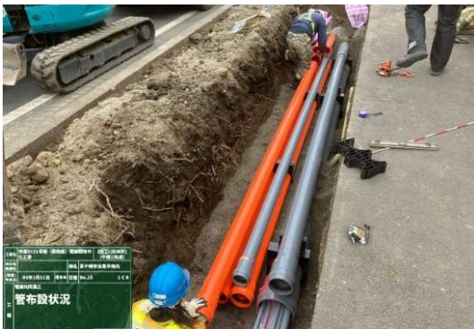
(主たる部分の施工状況写真1)
