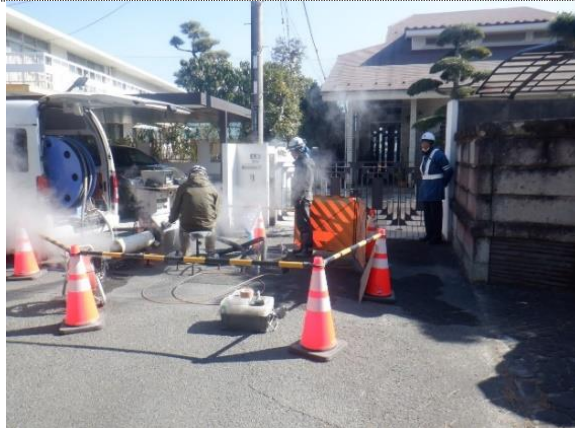
(主たる部分の施工状況写真(管渠内面被覆工))
