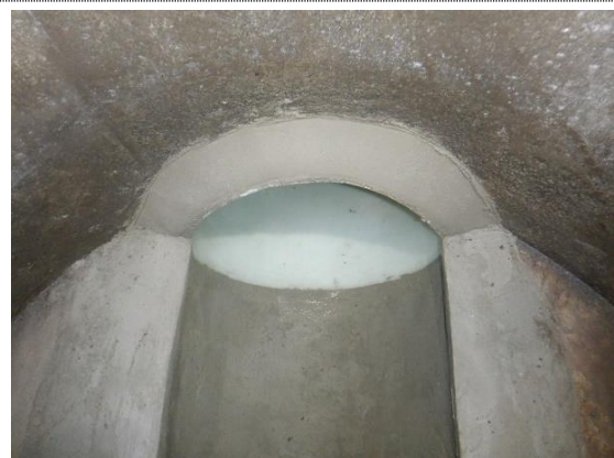
(工事完了写真(管渠内面被覆工))
