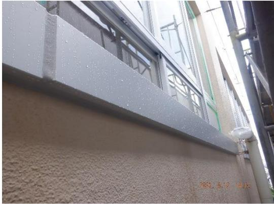
(雨漏り防止対策としてのサッシ下部面台を覆う新設水切)
