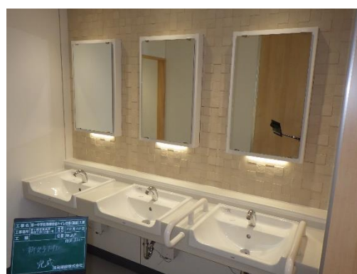
（完成写真 女子トイレ洗面）
