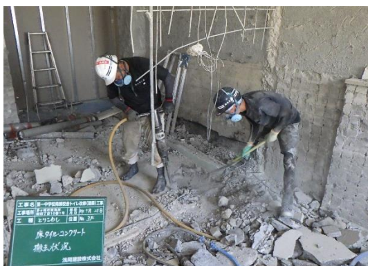
（主たる部分の施工状況写真）
