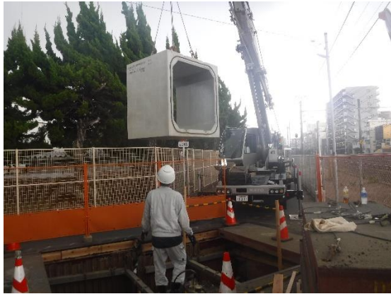
(線路近接部のボックスカルバート布設)
