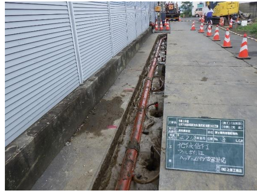
(地下水位低下工の施工)
