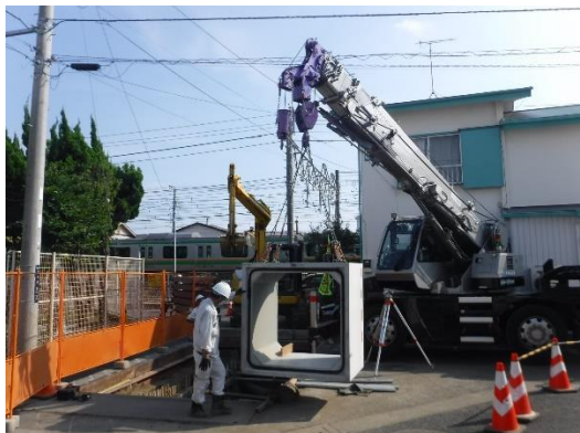
（主たる部分の施工状況写真）
