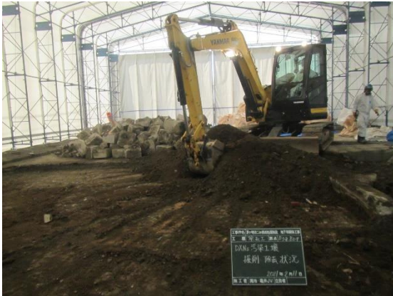
(汚染土壌掘削状況)
