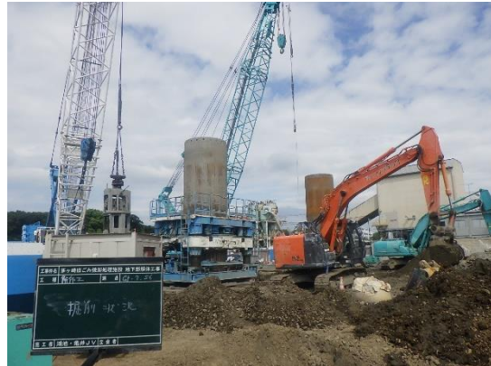
(オールケーシング工法による地下部解体状況)
