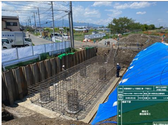
（主たる部分の施工状況写真）
