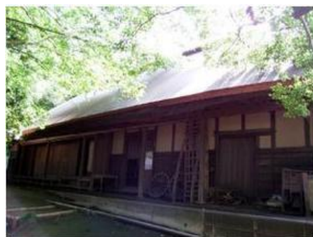
写真 17 旧三橋家住宅
