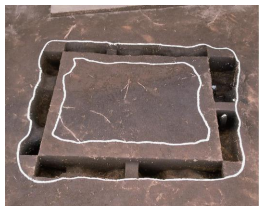
写真 25 布掘りの側柱建物（H 9 掘立）東から （写真は布掘りの溝の一部を掘ったもの）
