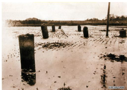
写真 12 旧相模川橋脚 出現時の様子
