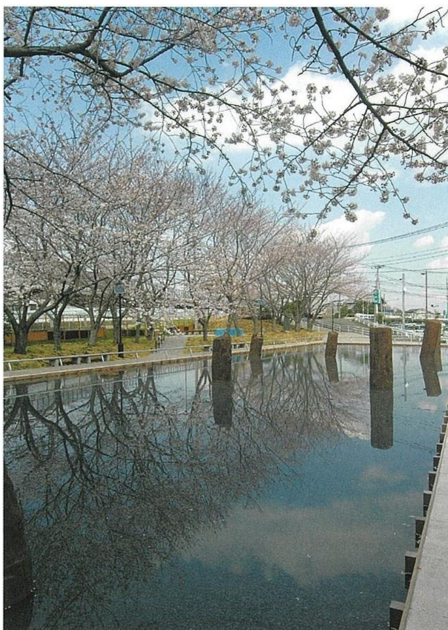
写真 21 保存整備後の旧相模川橋脚
