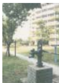
地下貯留した雨水を散水に利用
