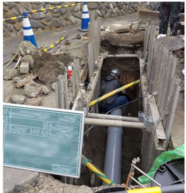
写真 4.4 管路施設改築の様子
