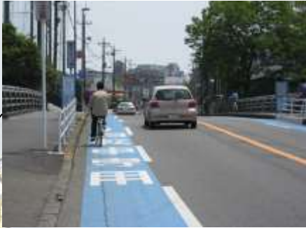
県道45号丸子中山茅ヶ崎線の 自転車専用通行帯（900m）
