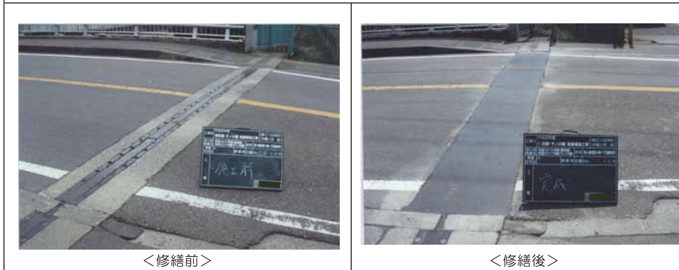
伸縮装置の取り換え状況
