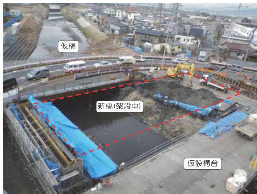
写真-1.4 神奈川県で施工している大曲橋の架け替え状況（平成 25 年 2 月撮影） （上側が仮橋、下側仮設構台、その間に新橋を架設中）
