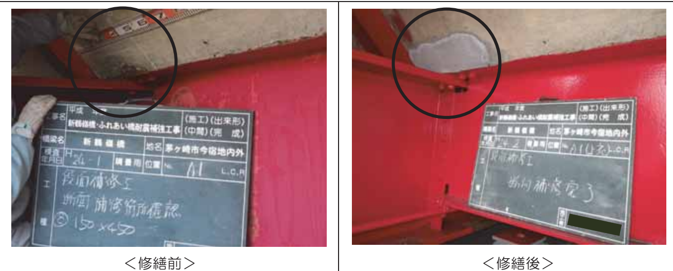
断面修復状況
