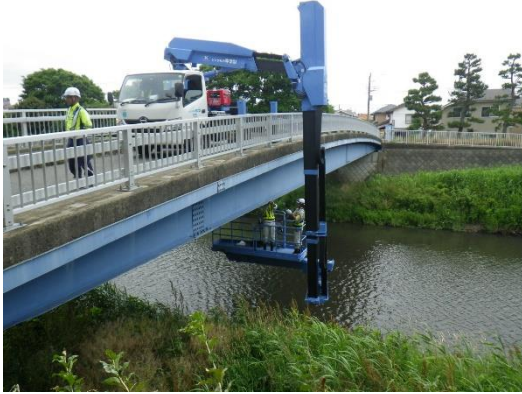
写真6-1 点検状況（中原橋）
