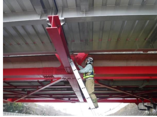
写真6-2 点検状況（新鶴嶺橋）
