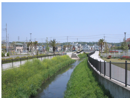
駒寄川の多自然型護岸
