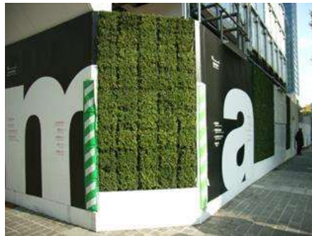
仮囲いをデザインし、コーナー部を壁面緑化した例（丸の内）
