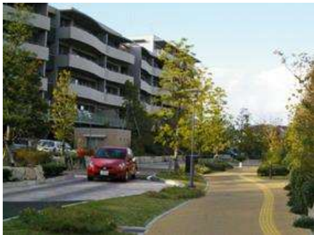
道路の舗装を変えたり蛇行させることで、自動車の運転者に注意を促した例（照葉のまち）
