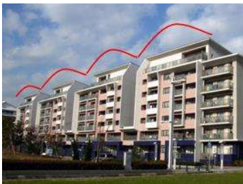
壁面の凹凸やデザインの繰返と分節化 1) を図った例 (幕張ベイタウン)
