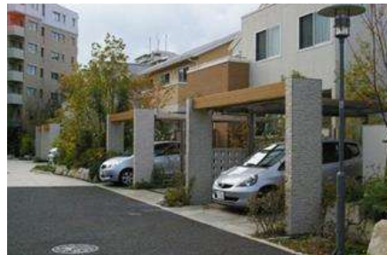
カーポートをデザインし、通り沿いの表情づくりに配慮した例（照葉のまち）
