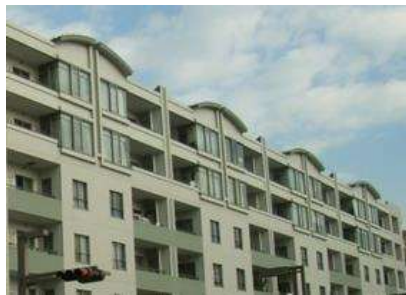
ヴォールト屋根 1) を用いた屋根形状の例 (幕張ベータウン)
