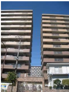
住棟の中高層部の壁面を分棟し空に視線の抜けが感じられる例（鎌倉市）
