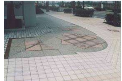
まちかどの舗装面に方位を入れる等の工夫を行った例 (幕張ベイタウン)
