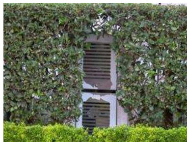
戸建住宅地におけるメーターボックスの修景例（柏市）
