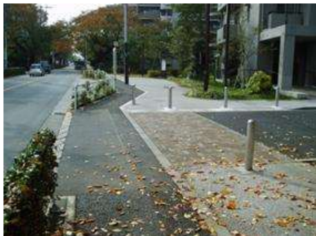
交差点部の舗装材を変え、運転者に注意を促している例（サンヴァリエ桜堤）
