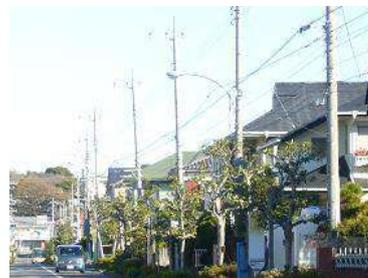
民地に設置し街灯を共架して集約した電柱 (高田)
