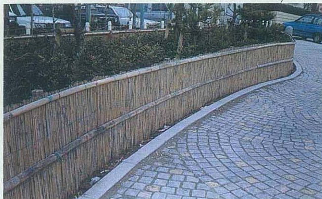
●片瀬東浜 藤沢市 歩車道境界の植栽帯に設置された自然竹使用の垣根である。
