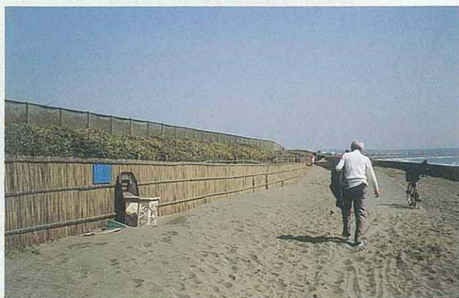
防風ネットの足元植栽
