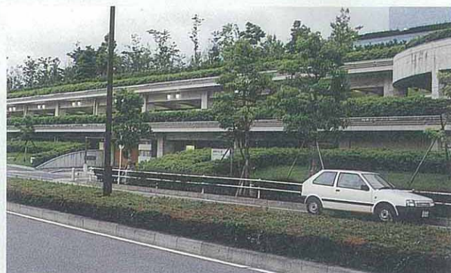
●多摩センター立体駐車場 多摩市
