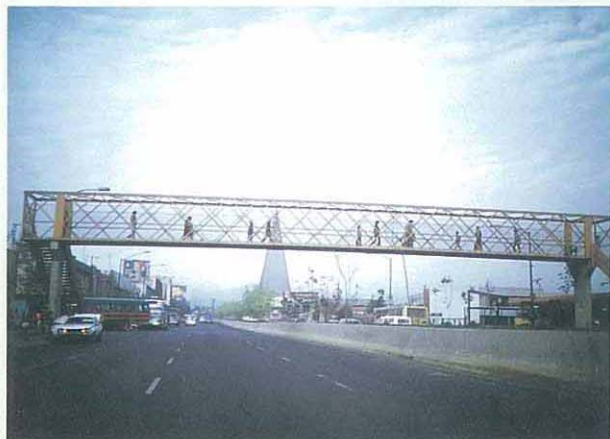
●メキシコシティ 細いトラスと薄いスラブによって構成された歩道橋。色彩は薄いレモンイエローで軽快性と楽しさを演出している。
