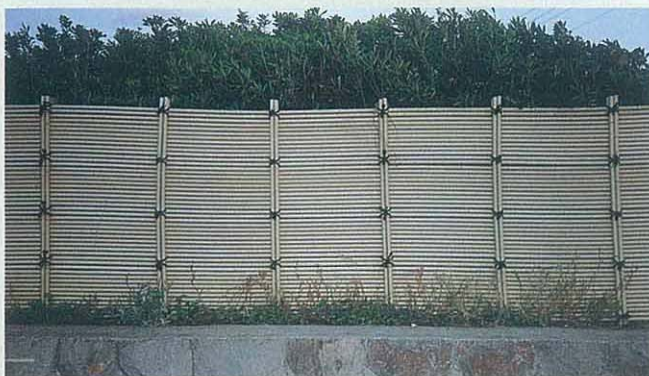
●鎌倉海岸 鎌倉市 公園の植栽に取り付けられたプラスチック製の砂防柵。防風効果も高く、褪色や破損に対する耐久性も高い。
