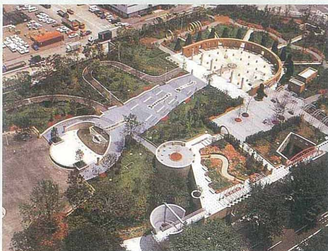
●山下公園立体駐車場 横浜市
